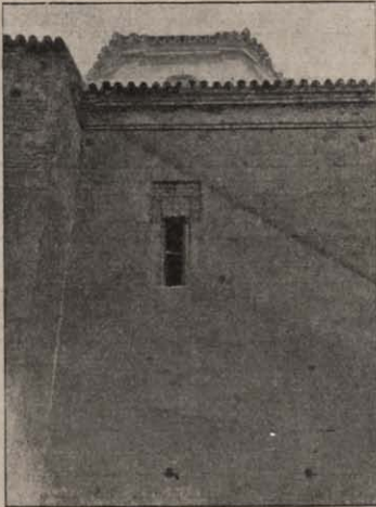
La fenêtre de la cellule de Colomb.
