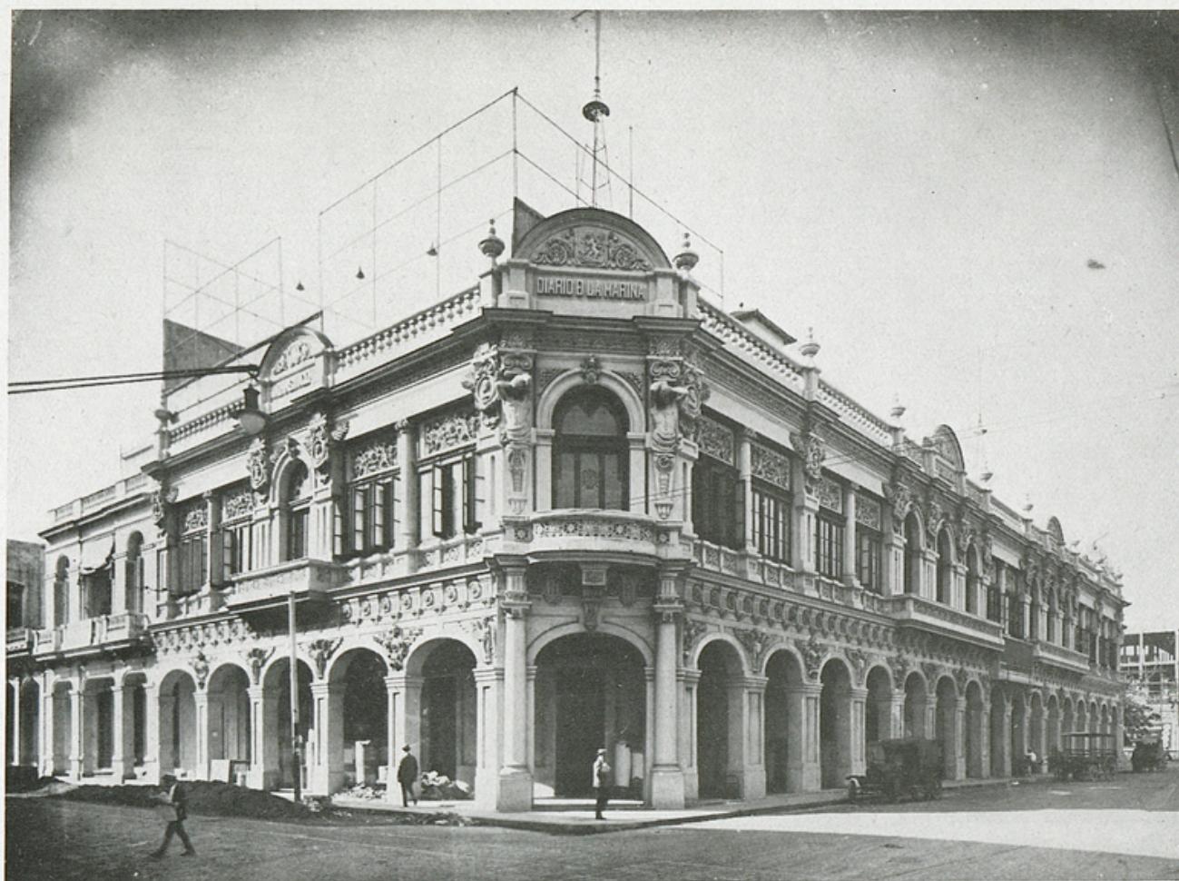
Edificio del Diario de la Marina, fundado en 1832, decano de la Prensa cubana.
