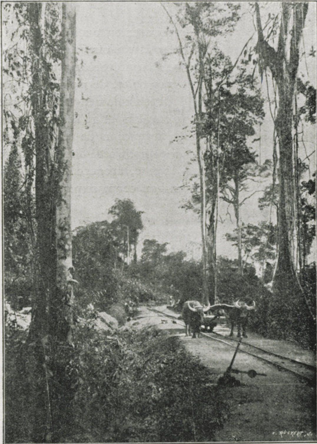
VOIE DECAUVILLE DE SAINT-LAURENT A SAINT-JEAN (d'après une photographie)
