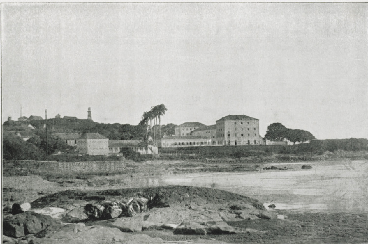
CAYENNE. — LE FORT CÉPÉROU, LA CASERNE ET LA BATTERIE (d'après une photographie de M. Chaumier. de Cayenne).
