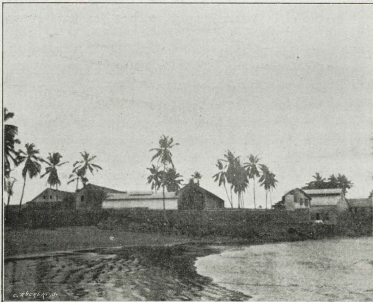
PÉNITENCIER — VUE PRISE DE LA PLAGE DES COCOTIERS (d'après une photographie de l'auteur).
