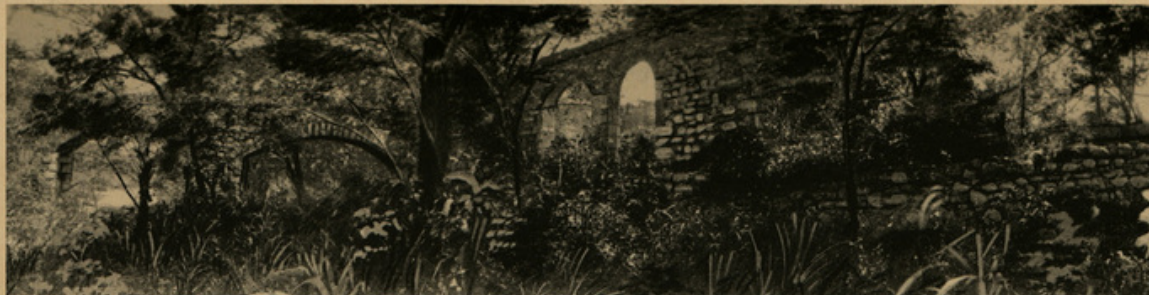
AQUEDUC DE L'HABITATION LAMARDELLE
