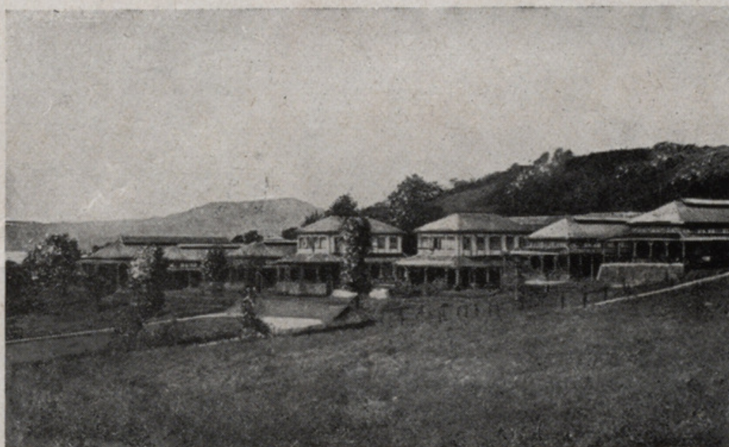
46. Les bâtiments de l'Hôpital Civil de Fort-de-France.
