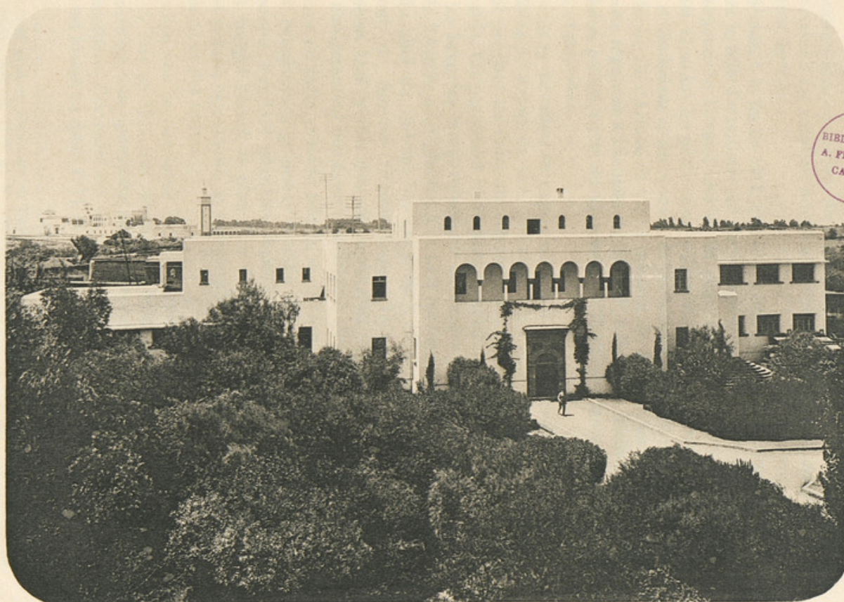
Bâtiment du Service Géographique, à Rabat.
