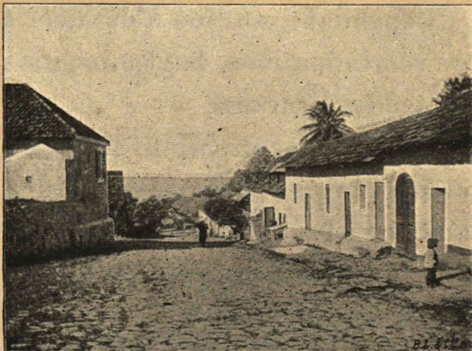
HABITATION PERRINELLE. — QUARTIER DES NÈGRES.
