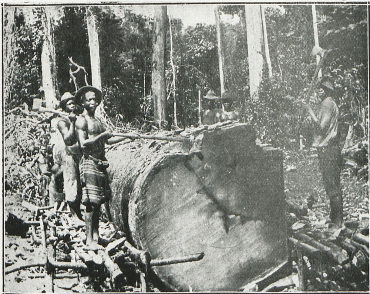
Photo Agence écon. du Cameroun. — Cliché Agence générale des Colonies. Équarrissage d'une bille de bois à la hache.
