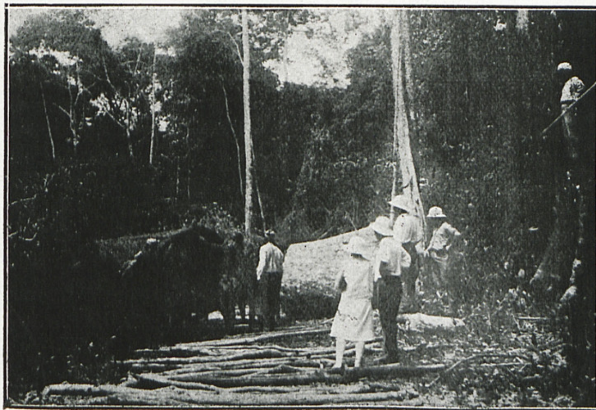
Photo Aubréville. — Cliché Agence générale des Colonies. Mise sur chariot, à l'aide de crics, d'une bille d'Acajou (Côte d'Ivoire).
