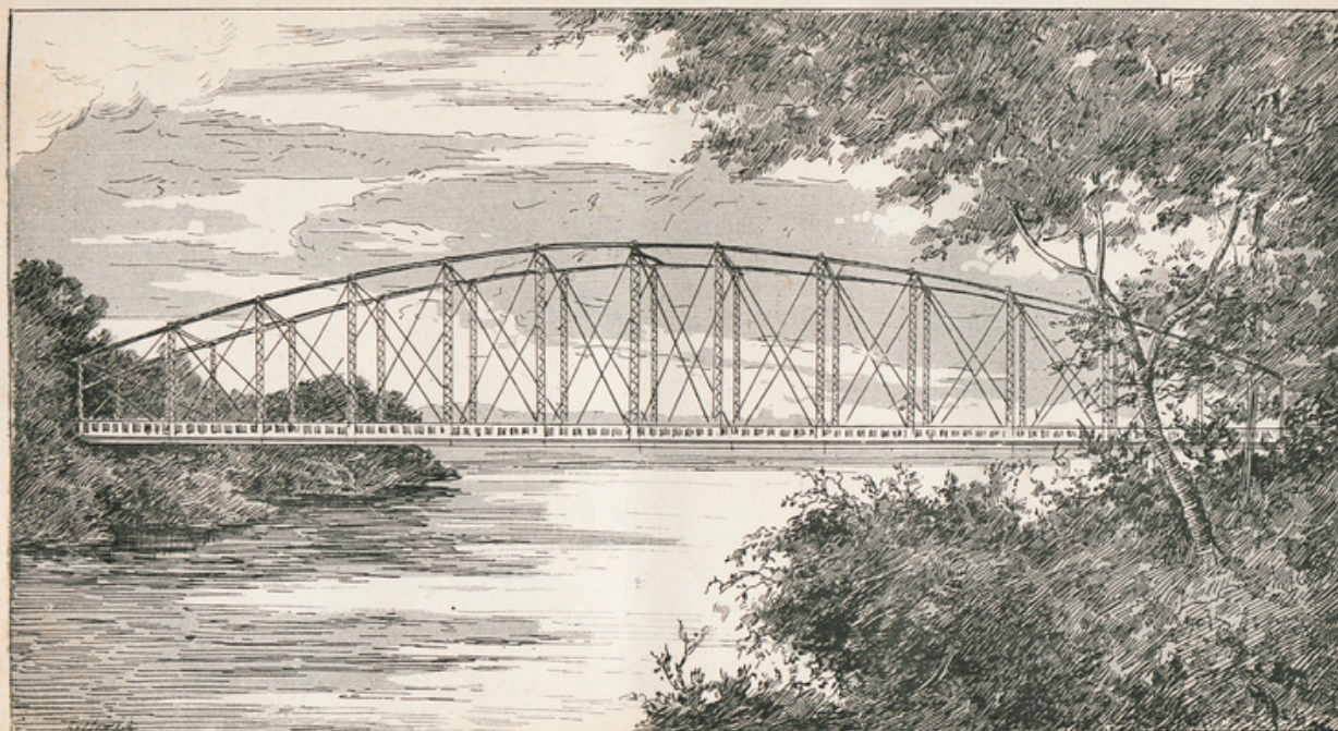
PONT SUSPENDU SUR L'ARTIBONITE
