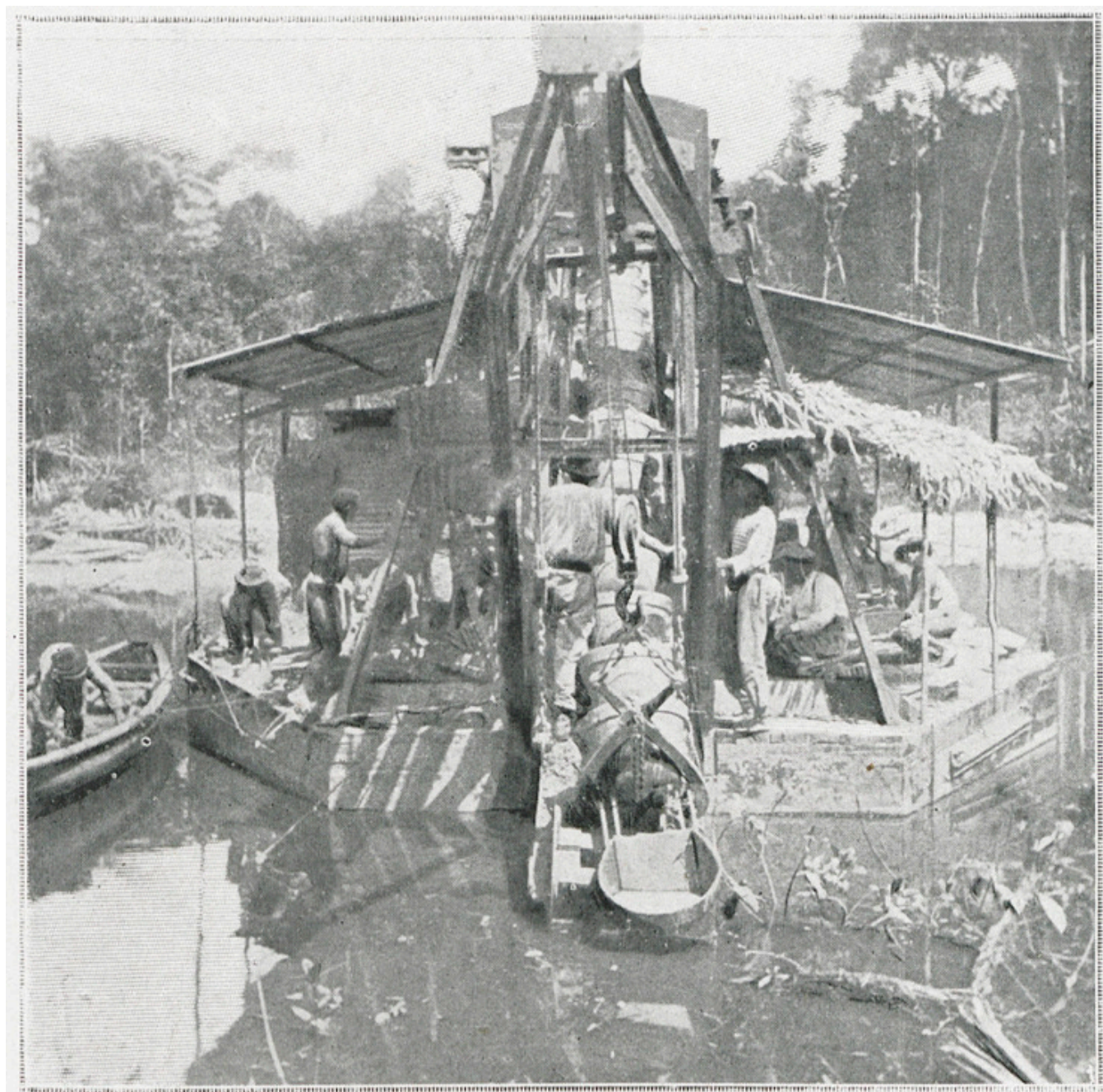
Drague à or vue de l'avant : les godets, entraînés sur une chaîne sans fin, prennent au fond de l'eau l'alluvion.
