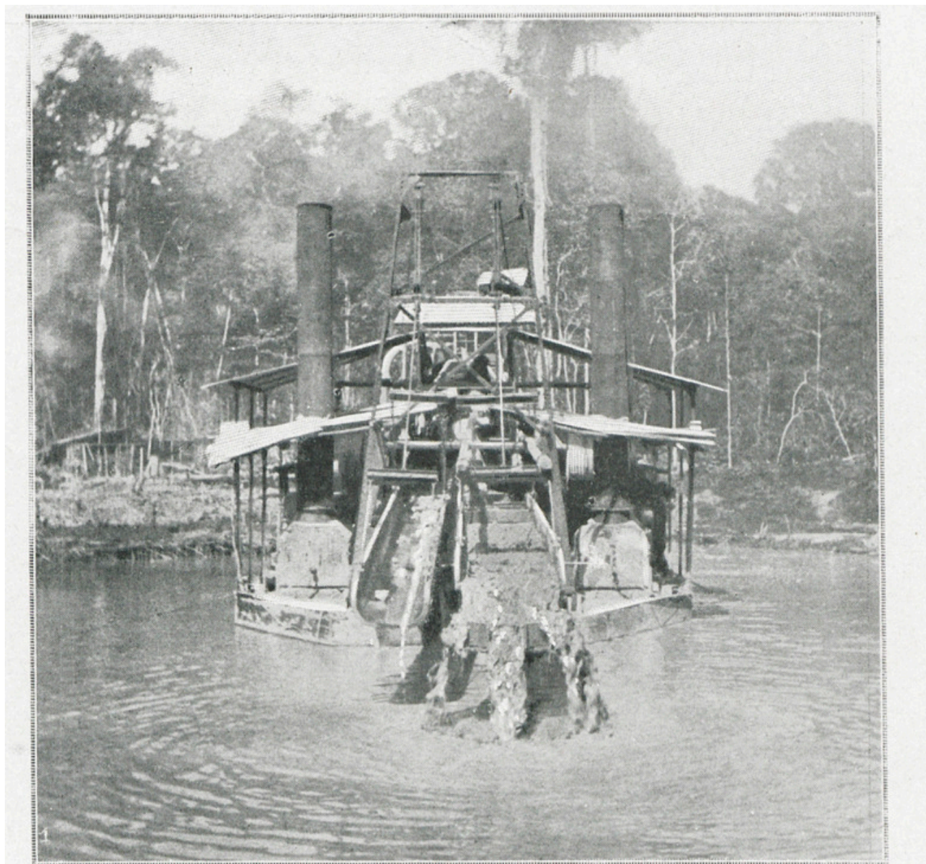
La même drague vue de l'arrière : la boue aurifère, jetée par les godets sur le sluice incliné, passe sur des grilles qui retiennent l'or.
